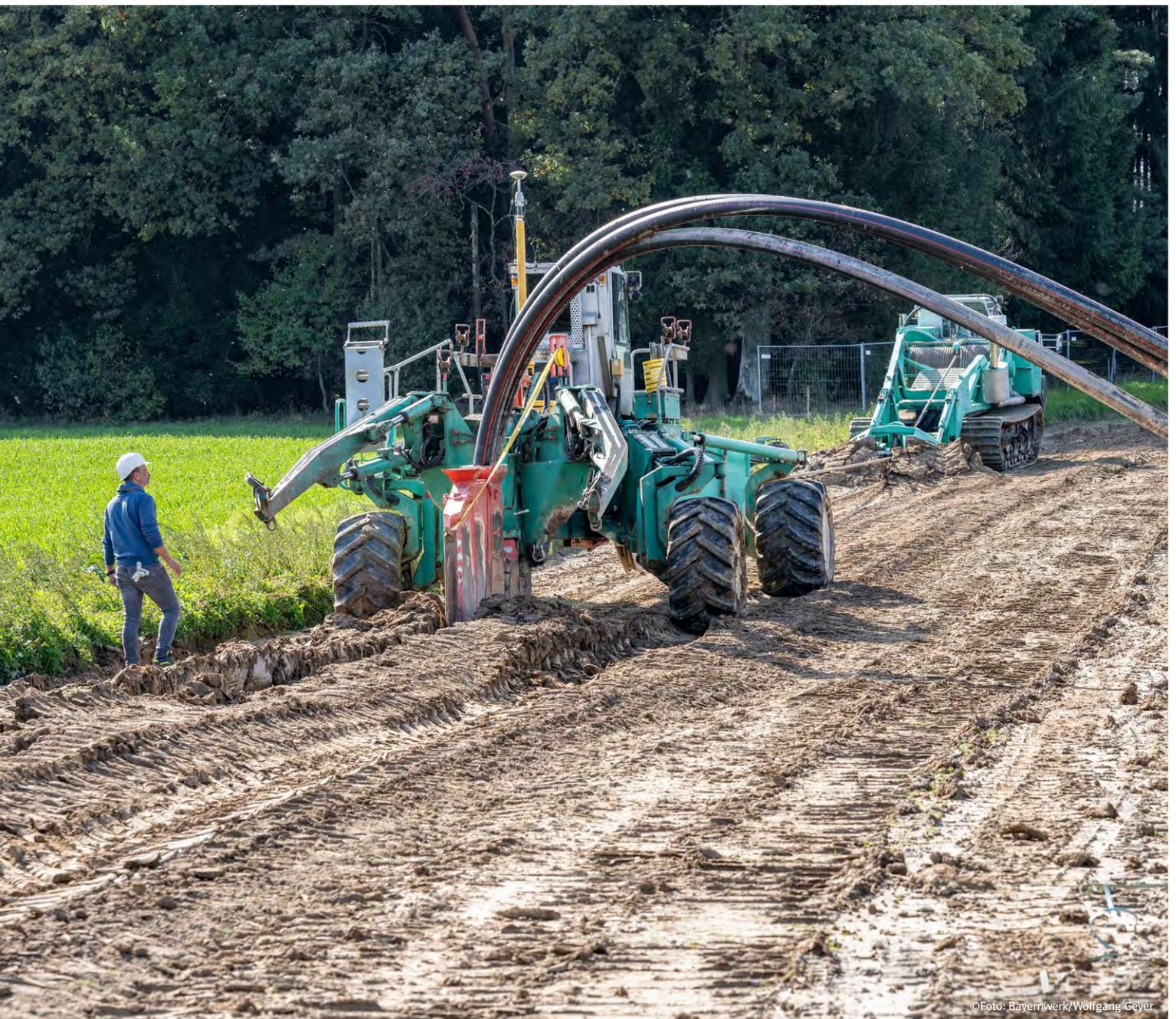
**1 Rohre:** Die Rohre werden passend auf der Trasse bereitgelegt, in der Fachsprache „vorgestreckt“.
