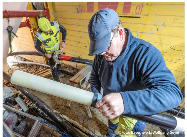
In der Muffengrube werden zwei Kabelstücke verbunden.
