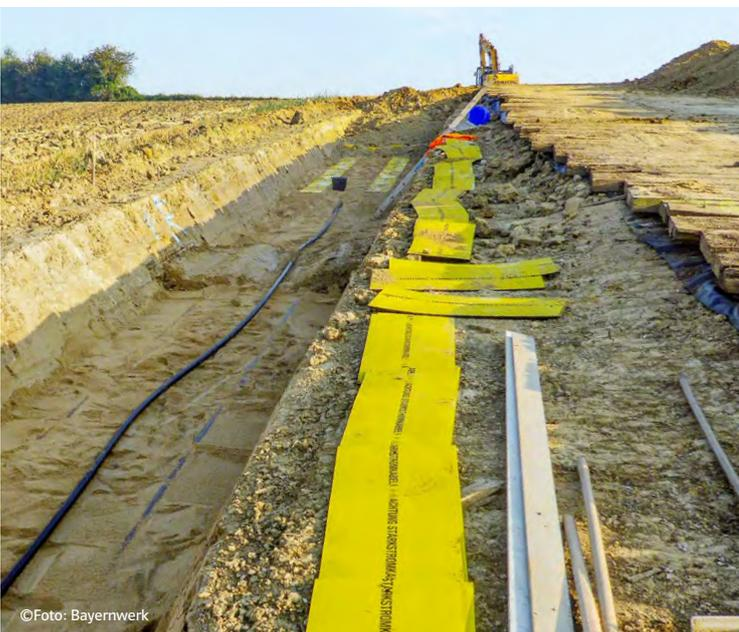
Die Abdeckplatten aus Kunststoff schützen die darunter liegenden Kabel.
