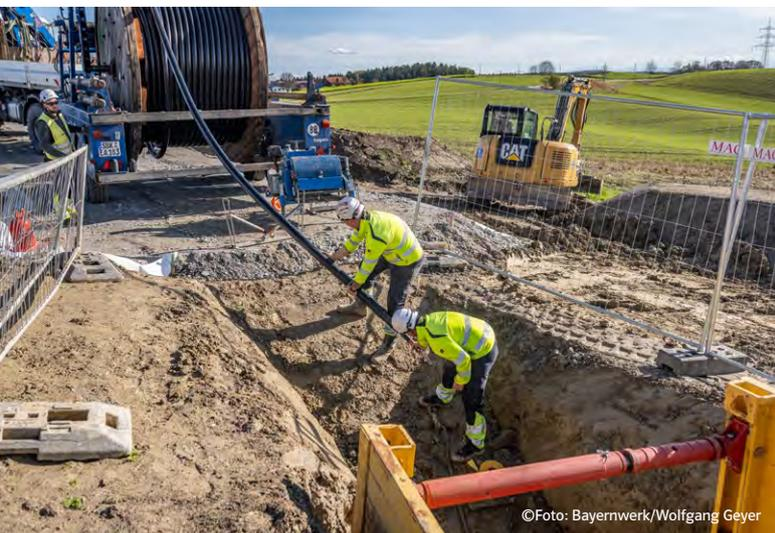
Bauarbeiter ziehen an einer Muffengrube die Kabel ein.
