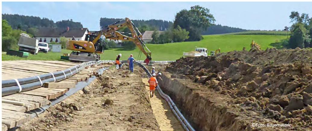
Bauarbeiter verlegen die Leerrohre entlang der Strecke.
