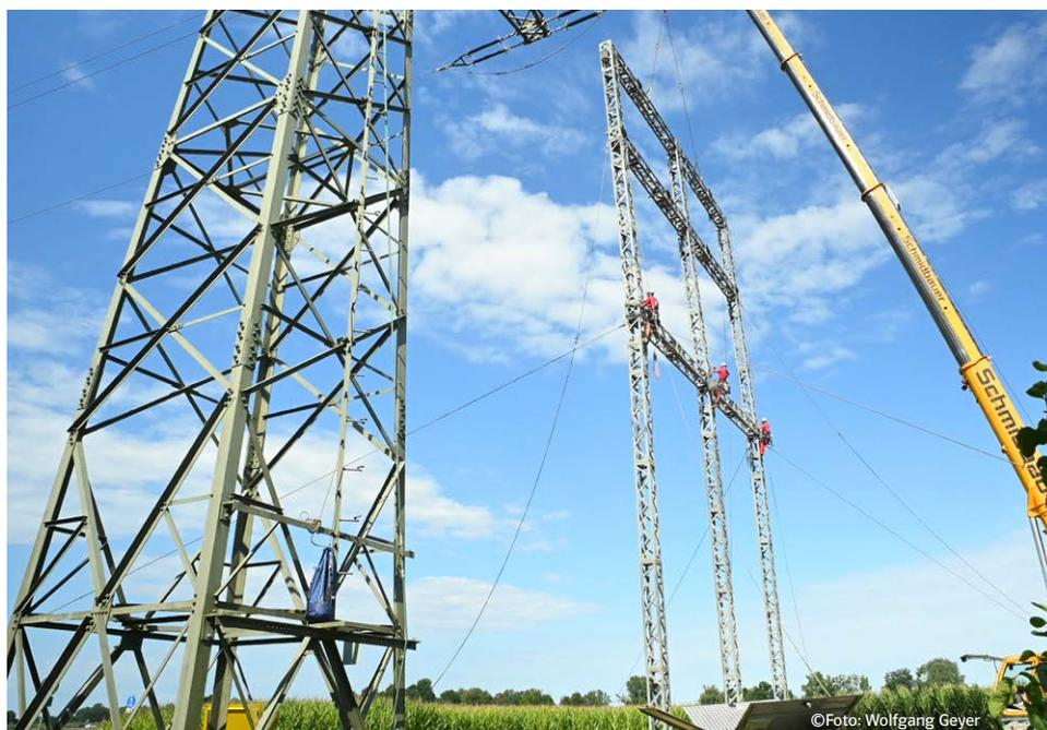
Provisorien tragen die Leiterseile während der Bauarbeiten am Mast.
